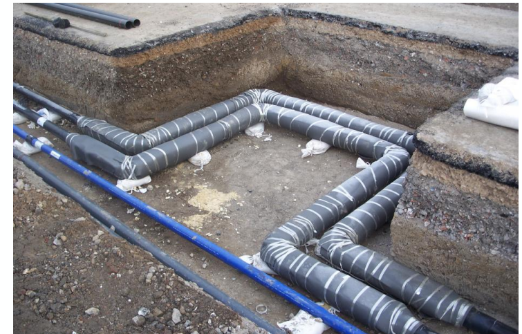
Aus- und Umbau der Fernwärme Quelle: https://commons.wikimedia.org/wiki/File:Fernw%C3%A4rme_u_bogen.jpg
