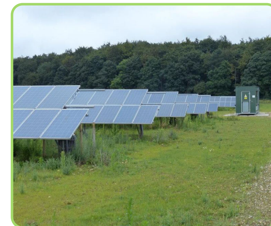
Freiflächen-PV-Anlage Quelle: Wikimedia Commons
