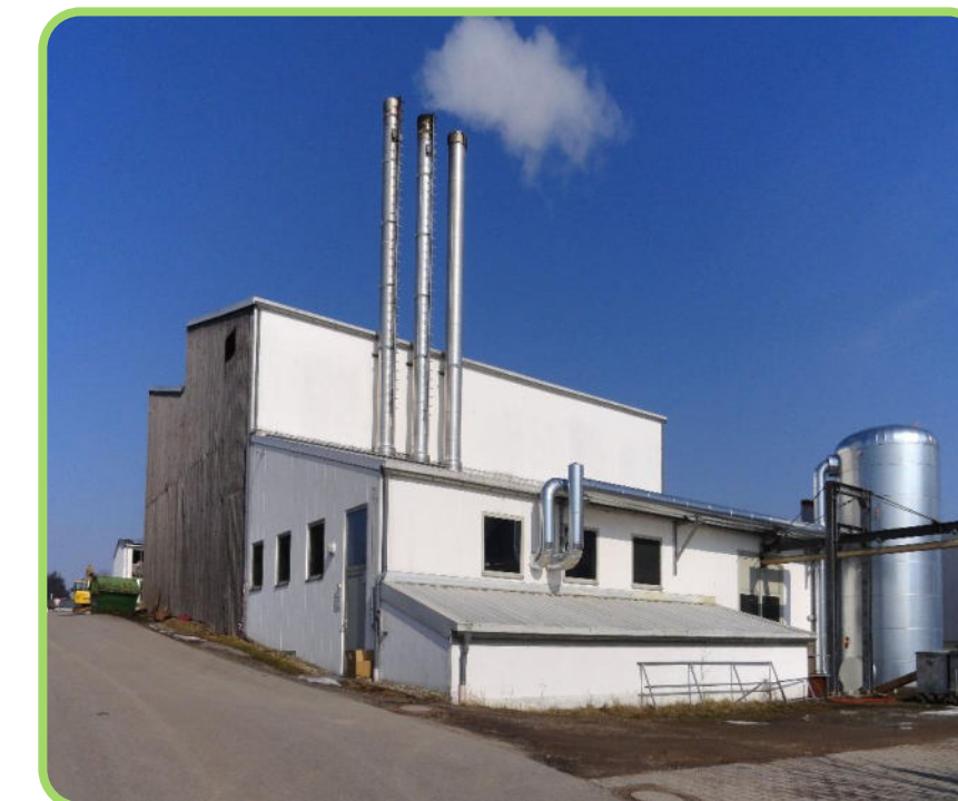
Biomasseheizwerk Mitterfels Quelle: Wikimedia Commons
