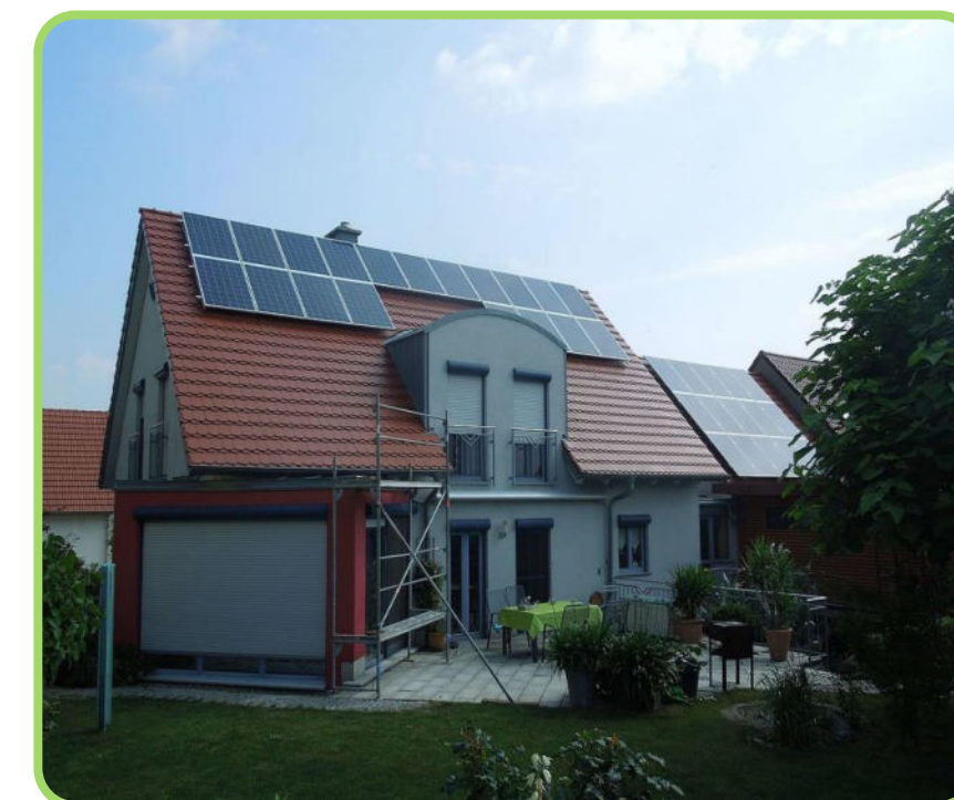
Einfamilienhaus mit Dach-PV Quelle: Wikimedia Commons
