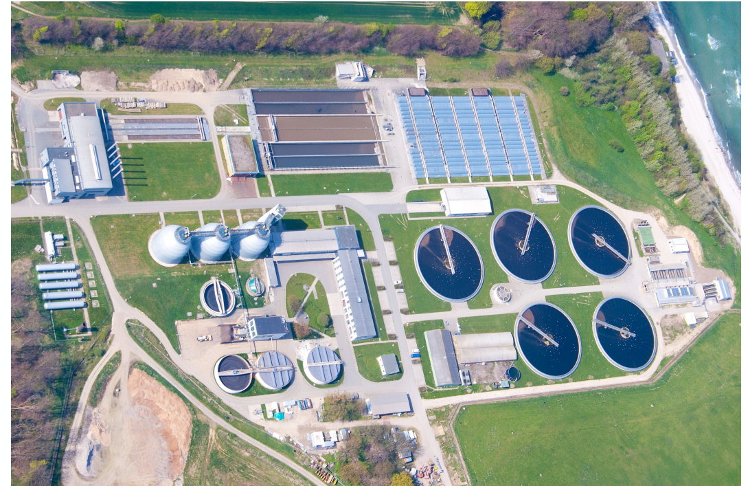
Kläranlage Kiel-Bülk mit 380.000 Einwohnerwerten (EW), Photo Von Louis-F. Stahl, CC BY-SA 3.0 de, https://commons.wikimedia.org/w/index.php?curid=20913394
