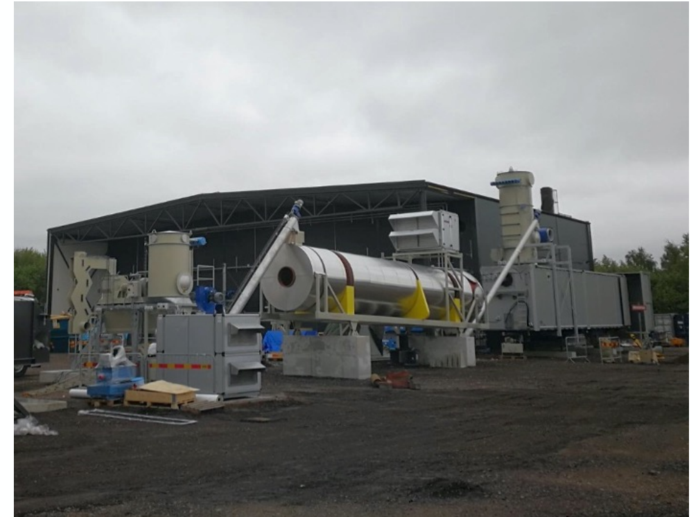
Erste Pyrolyse-Anlage in Schweden bei Abfallentsorger NSR in Helsingborg produziert 1.500 t/a Pflanzenkohle und vermeidet 3.500 t CO 2 /a, Photo By Hauke Schmüling
