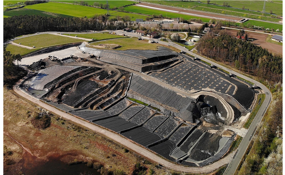
Luftaufnahme der Sondermülldeponie für Abfälle der Klasse 3 im bayerischen Raindorf bei Fürth (2020), Photo Von HaSe - Eigenes Werk, CC BY-SA 4.0, https://commons.wikimedia.org/w/index.php?curid=89131123
