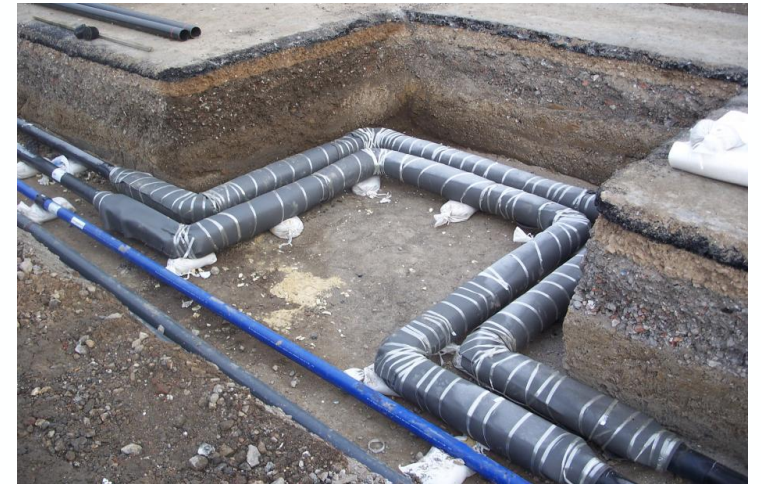
Aus- und Umbau der Fernwärme Quelle: https://commons.wikimedia.org/wiki/File:Fernw%C3%A4rme_u_bogen.jpg
