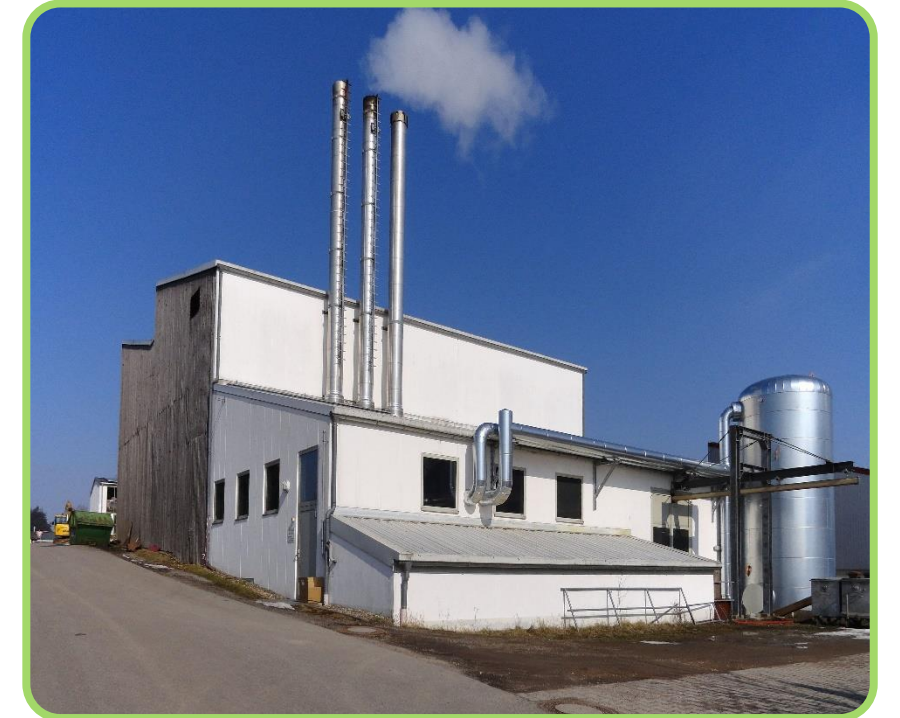
Biomasseheizwerk Mitterfels Quelle: Wikimedia Commons
