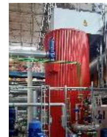
Power-to-Heat Elektroheizkessel 20 MW, 50 MW und 60 MW
