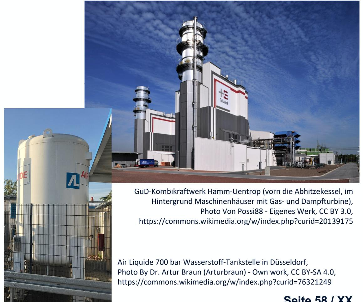
GuD-Kombikraftwerk Hamm-Uentrop (vorn die Abhitzeessel, im Hintergrund Maschinenhäuser mit Gas- und Dampfturbine), Photo Von Possi88 - Eigenes Werk, CC BY 3.0, <https://commons.wikimedia.org/w/index.php?curid=20139175>
