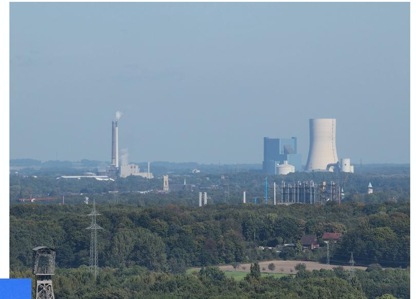
Kraftwerk Datteln, Links die stillgelegten Altblöcke 1–3, rechts der neu gebaute Block 4 mit neuem Kühlturm (Höhe 180 Meter),
