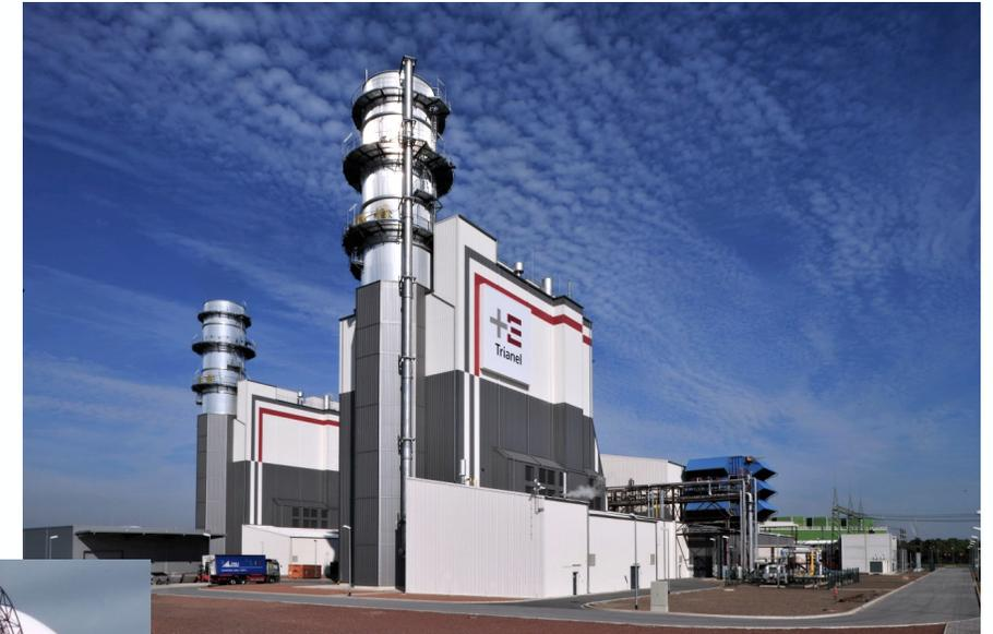
GuD-Kombikraftwerk Hamm-Uentrop (vorn die Abhitzeessel, im Hintergrund Maschinenhäuser mit Gas- und Dampfturbine), Photo Von Possi88 - Eigenes Werk, CC BY 3.0, <https://commons.wikimedia.org/w/index.php?curid=20139175>
